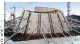
Installation des panneaux du cône de 6,20 m de haut.
