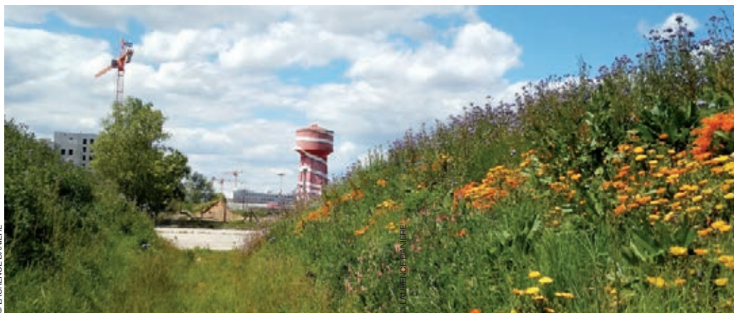
Terres végétales récupérées d'un chantier de parking, stockées en andains en attente de l'aménagement d'un espace public planté, au Carrée de soie (Lyon métropole).
