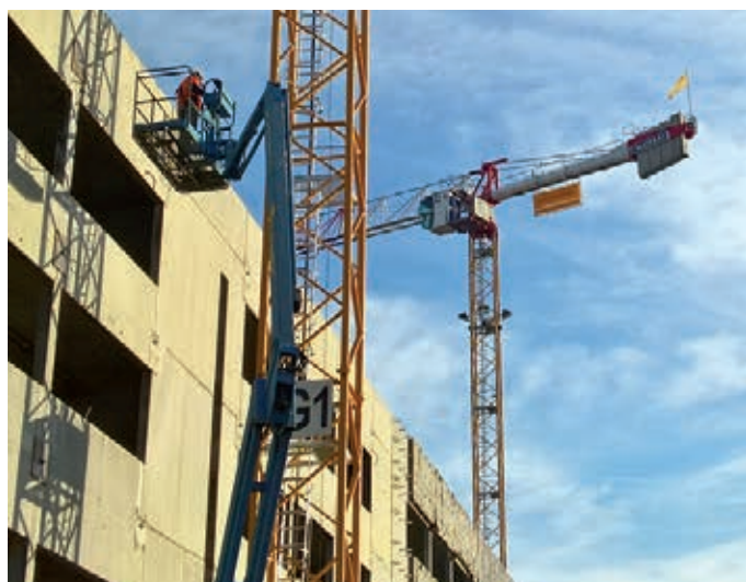
Chantier du 1 er immeuble. Un second bâtiment, cubique, sera prêt en 2018.
