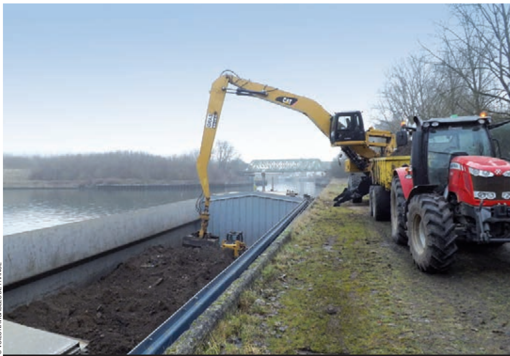
Le chantier de la future plateforme de Dourges (Pas-de-Calais) sert de démonstrateur à l'intégration du fluvial dans les grands chantiers comme le Canal Seine Nord Europe.
